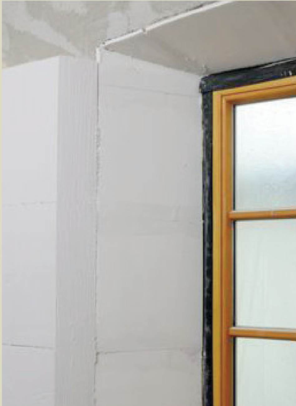
Abb. 27: Sto-Aeверо-Innendämmplatten in den Fensterlaibungen.
