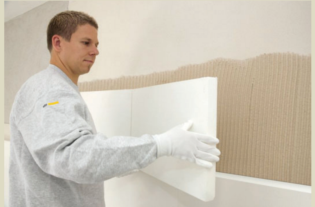
Abb. 35: Installation, Sto-Aeверо-Innendämmplatten
