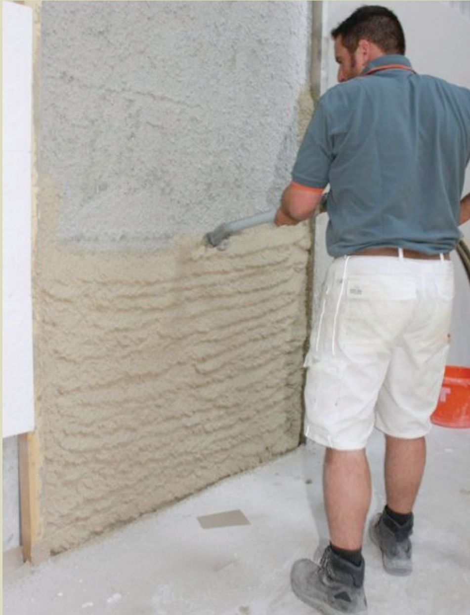
Abb. 25: Aerogel-Hochleistungsdämmputz wird mit der Verputzmaschine aufgespritzt und nachher glatt gezogen. Der weiche Dämmputz muss in einem weiteren Arbeitsgang mit einem gewebebearmierten Einbettmörtel versehen werden. (20)
