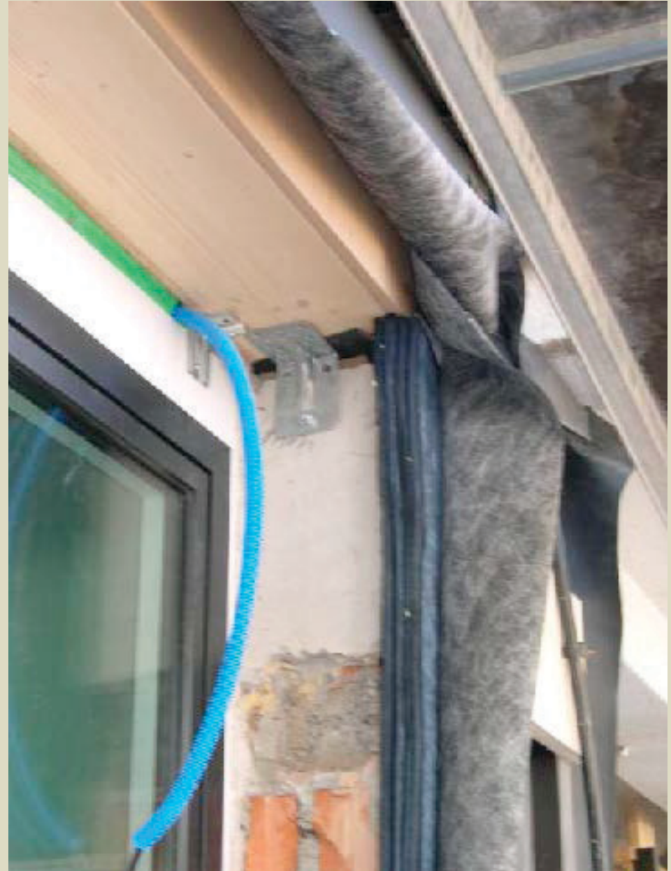
Abb. 26: Außenwanddämmung - Holzbau, mehrlagig, Dämmvlies, Spaceloft
