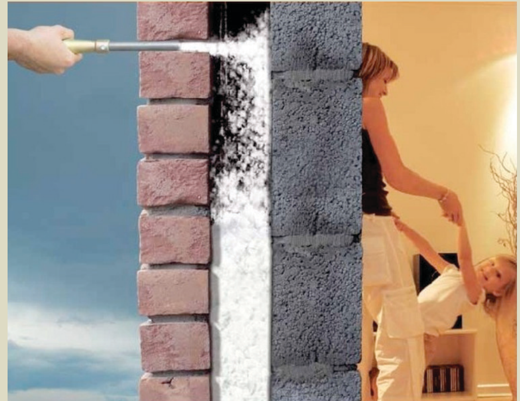
Abb. 22: Installationsprozess, Einblas-, Zwischenwandraum, Steinmauerwerk
