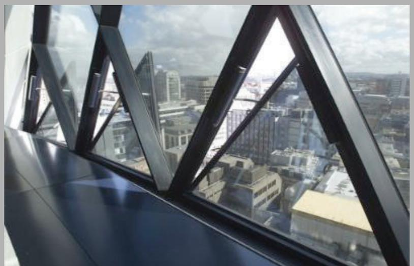
Atrienbelüftung bzw. Fassadenbelüftung
